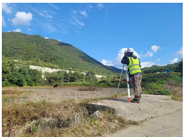
광파기를 이용한 측량 작업
